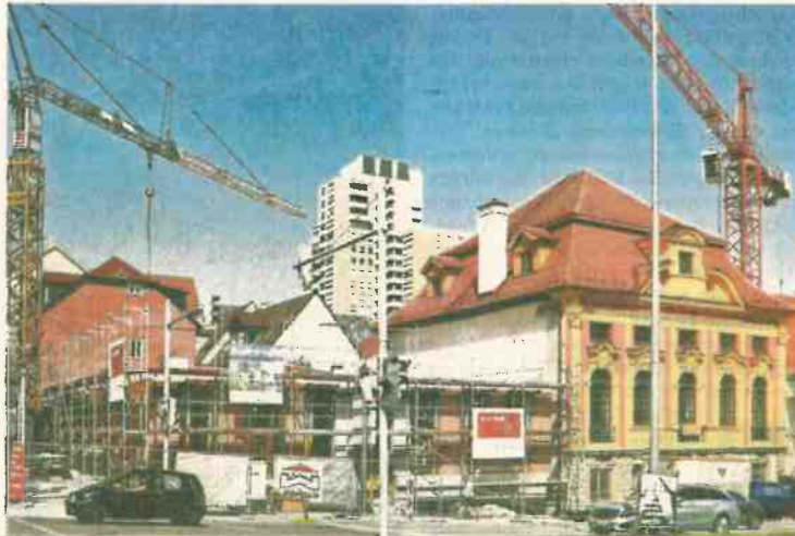
Der Kaffeeberg: Ein Quartier bekommt ein neues Gesicht.
