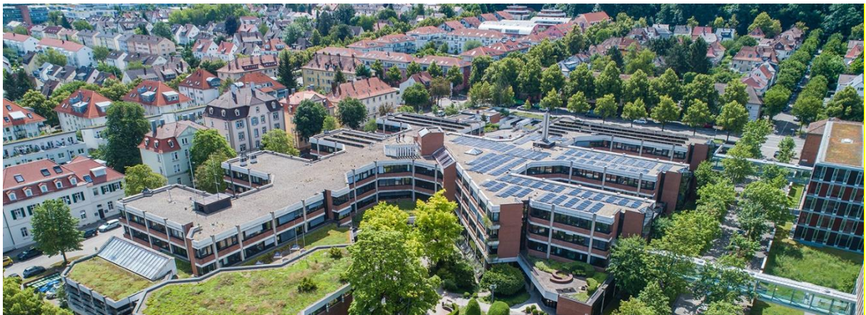
Abbildung 3 Kreishaus Ausbau der PV-Anlagen (Bildquelle: Landratsamt Ludwigsburg)
