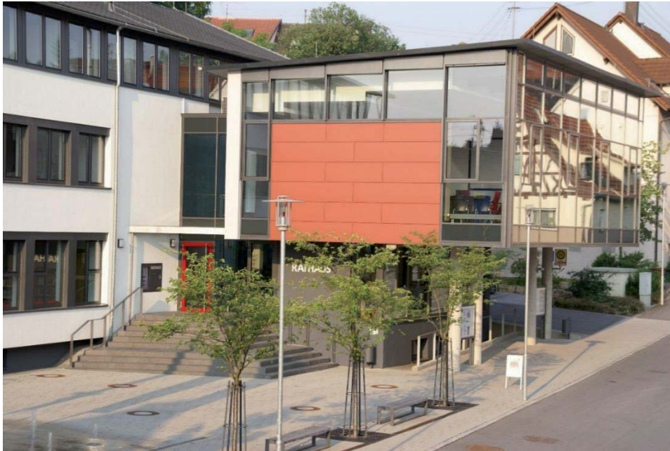
Abb. 113: Rathaus Erdmannhausen Quelle: Gemeinde Erdmannhausen
