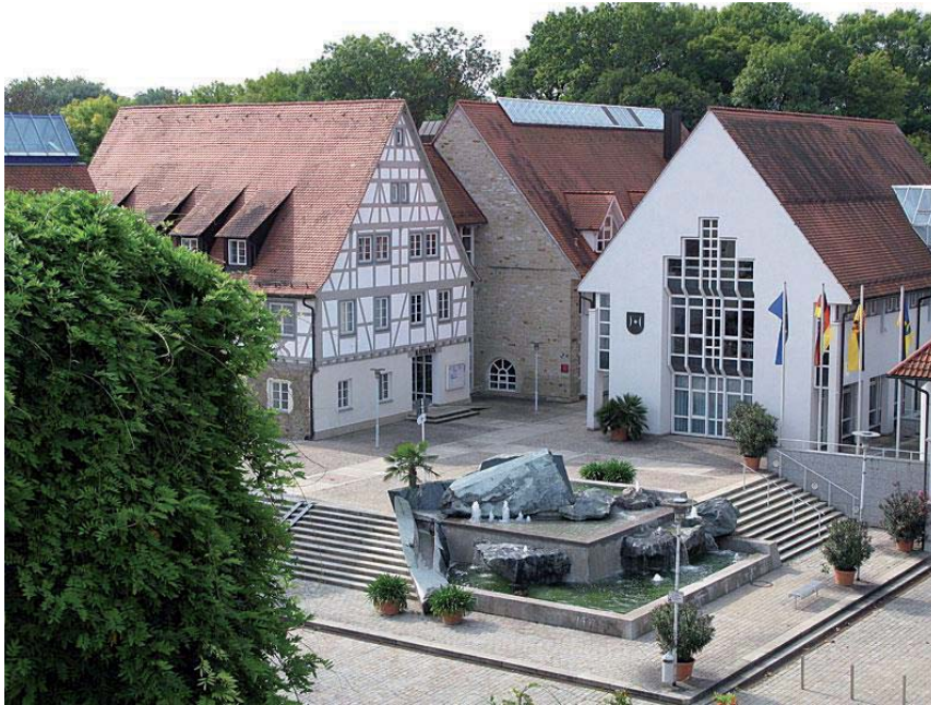
Abb. 59: Rathaus Schwieberdingen Quelle: Gemeinde Schwieberdingen
